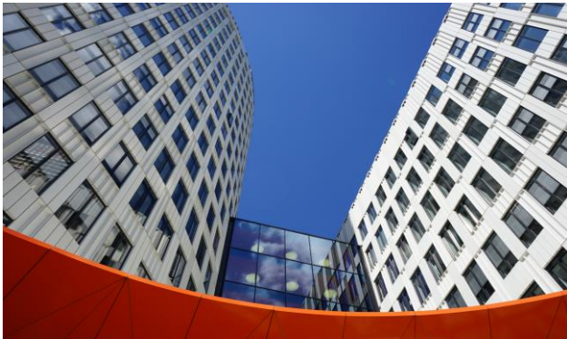
Leo (ehemals Poseidon-Haus), Frankfurt am Main
