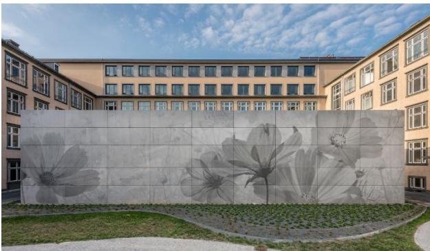
Barkhausenbau, TU Dresden
