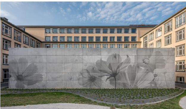
Barkhausenbau, TU Dresden
